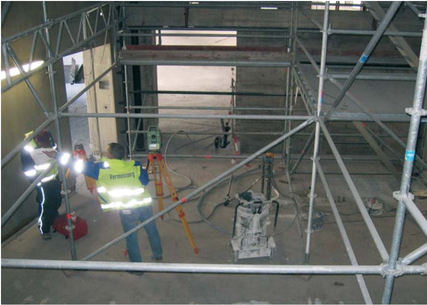
Sichtbehinderungen durch Baugerüste in mehreren Ebenen erleichterten die Vermessung nicht immer...
